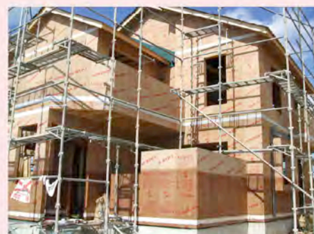
木質ボードに薬剤を塗布した例
